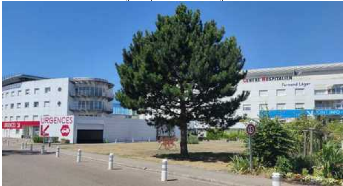
Point info du Centre Hospitalier
